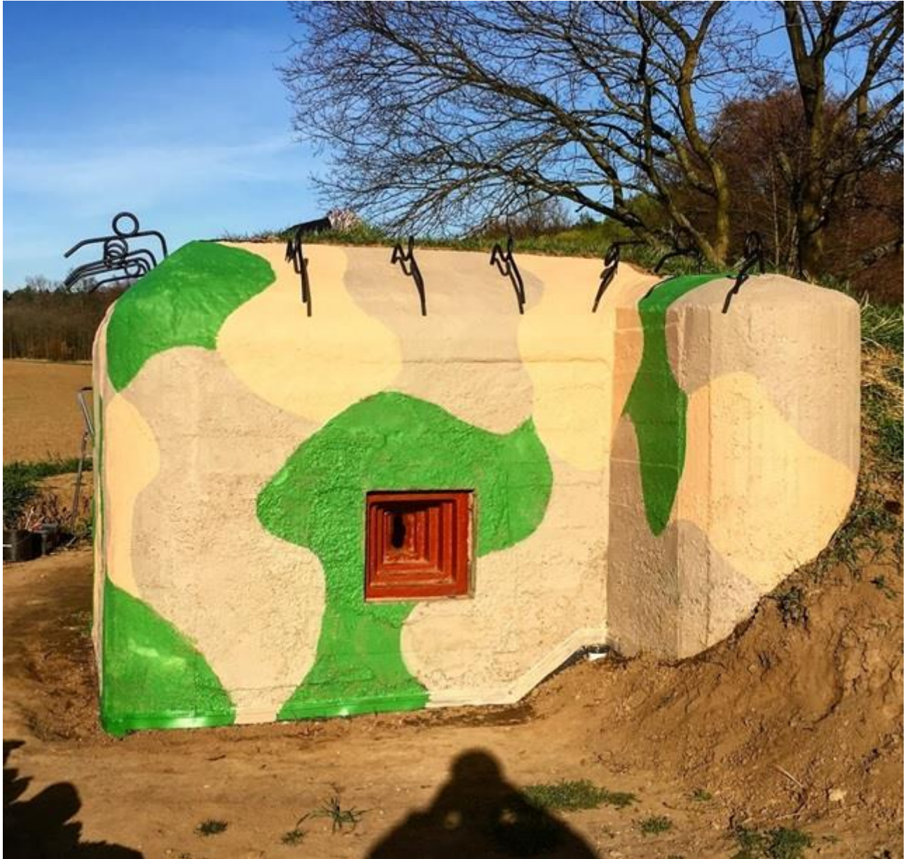
Stav bunkru po nátěru, duben 2018
