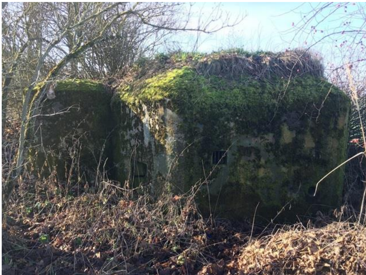
Stav bunkru před zahájením oprav, prosinec 2015
